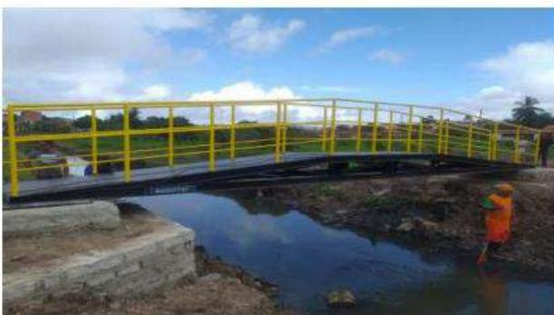
CONFECÇÃO INSTALAÇÃO DE 02 (DUAS) PASSARELAS METÁLICA (5,00 x 1,20m) NA AV. FILADELFO DORIA, BAIRRO INDUSTRIAL.
