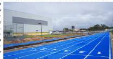
Praça de atletismo do CIE em construção | Foto: Aracaju/Emurb
