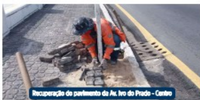
Recuperação do pavimento da Av. Ivo do Prado - Centro
