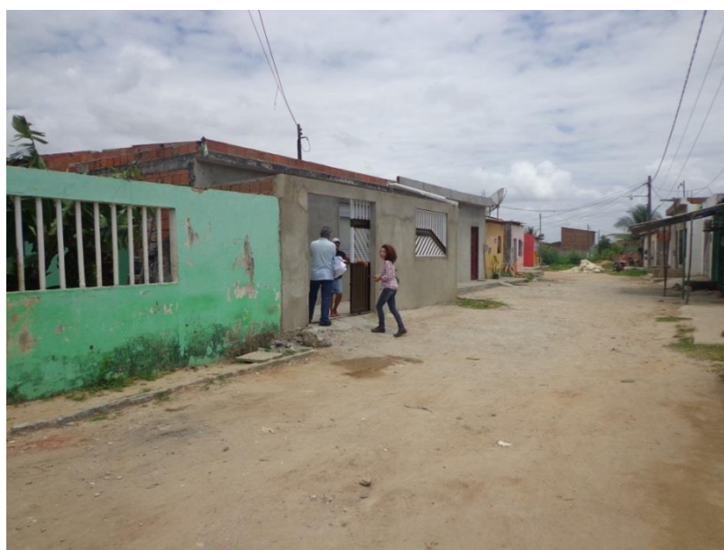
Figura 3.2 – Casas à esquerda onde ocorrerá desapropriação.
