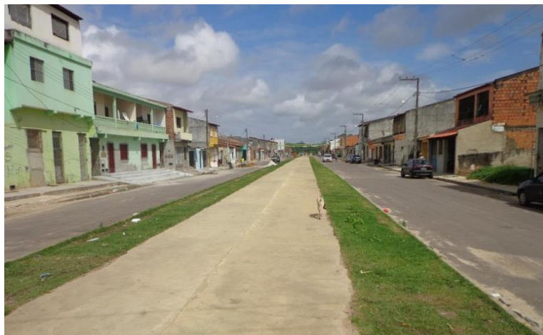
Figura 6.4 - Segmento de avenida pavimentada por onde passará a Av. Perimetral Oeste, no Bairro Olaria.
