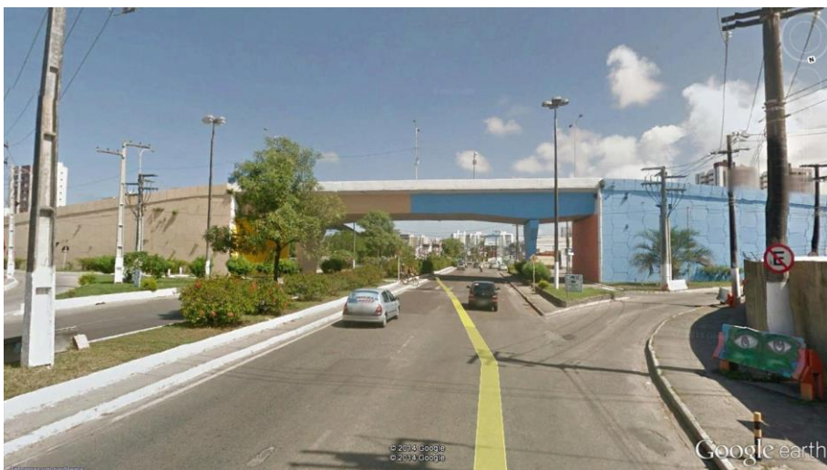
FIGURA 9 –ESTAÇÃO GONÇALO ROLLEMBERG
