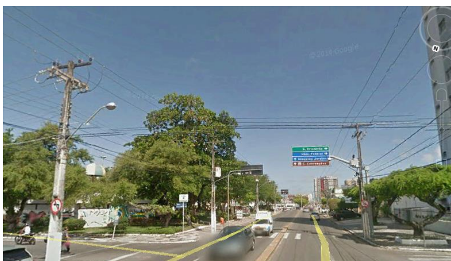
FIGURA 6 – ESTAÇÃO PÇA DA BANDEIRA – SUPRESSÃO DE ARVORES
