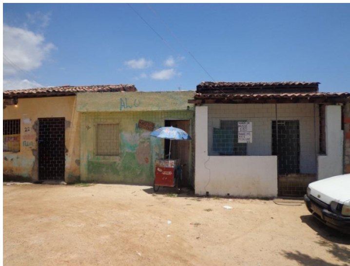
Figura 3.48– Casas que serão desapropriadas já no município de Nossa Senhora do Socorro.
