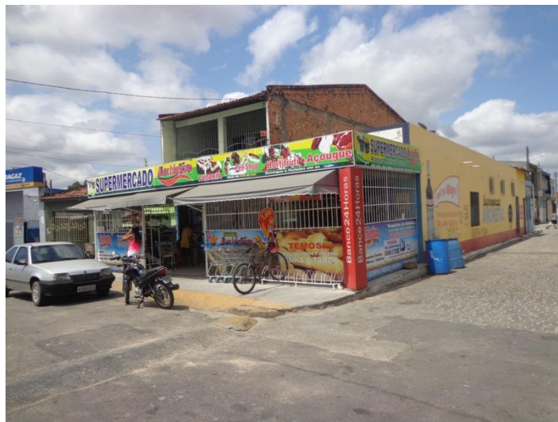
Figura 3.41 – Supermercado a ser retirado para passagem da avenida.
