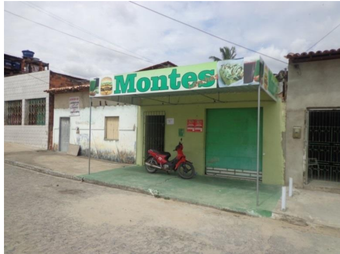
Figura 3.32 – Lanchonete á ser removida para passagem da avenida.
