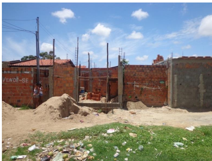
Figura 3.5 – Casa em construção que será retirada para passagem da avenida.
