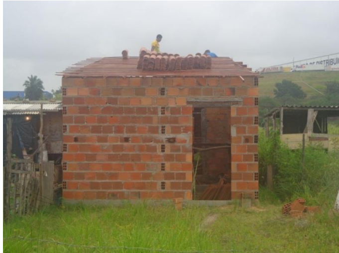
Figura 3.53 – Casa de alvenaria em construção no local.
