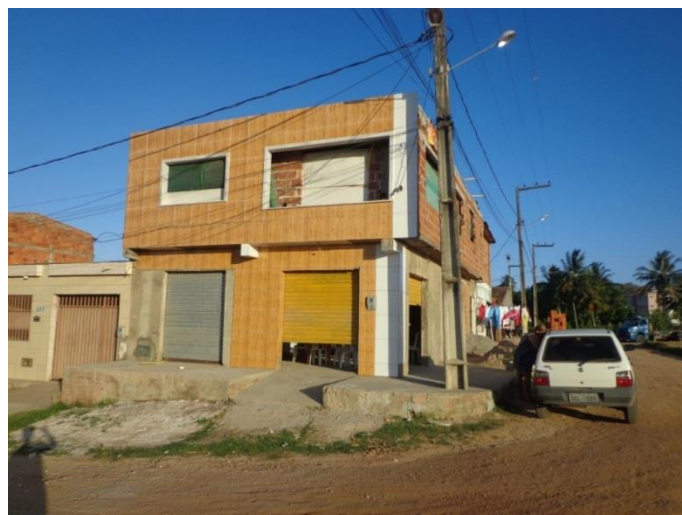
Figura 3.7 – Imóvel a ser desapropriado que é utilizado como estabelecimento comercial (em baixo) e como moradia (em cima).
