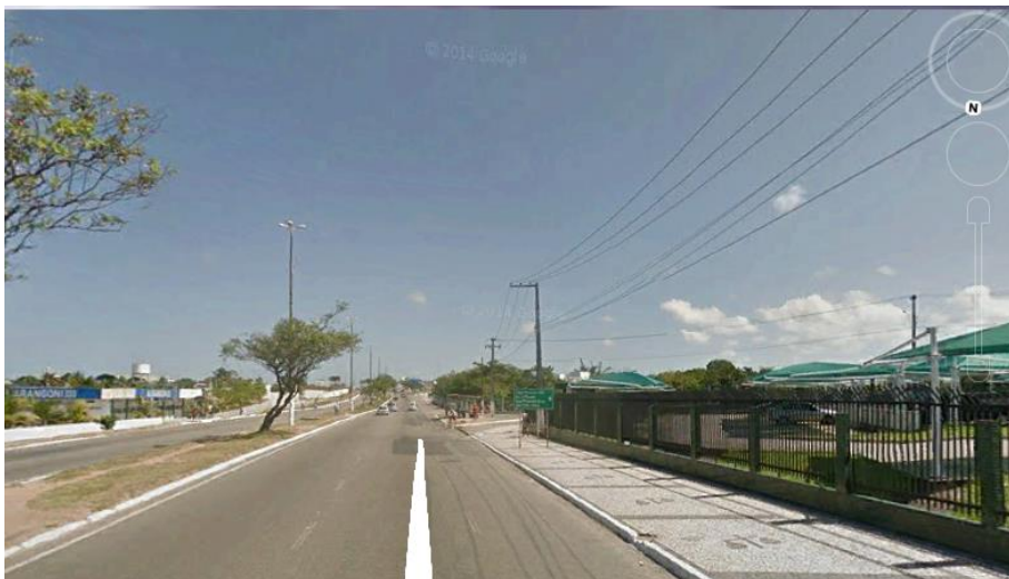
FIGURA 36 – ESTAÇÃO CENTRO ADMINISTRATIVO (VISTA LESTE)
