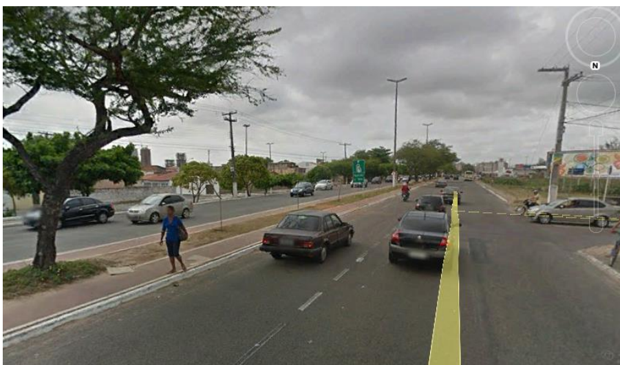
FIGURA 30 –ESTAÇÃO DOM PEDRO I (VISTA LESTE)
