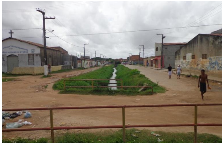
Figura 6.3 – Segmento de avenida não pavimentada por onde passará a Av. Perimetral Oeste, no Bairro Olaria.
