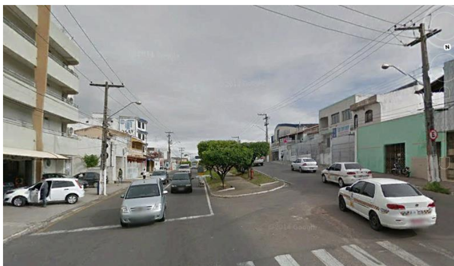
FIGURA 5 – ESTAÇÃO LARANJEIRAS – SUPRESSÃO DE ARVORES
