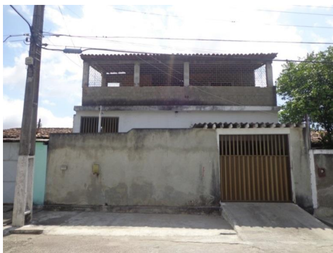
Figura 3.39 – Casa que deverá ser removida para passagem da avenida.
