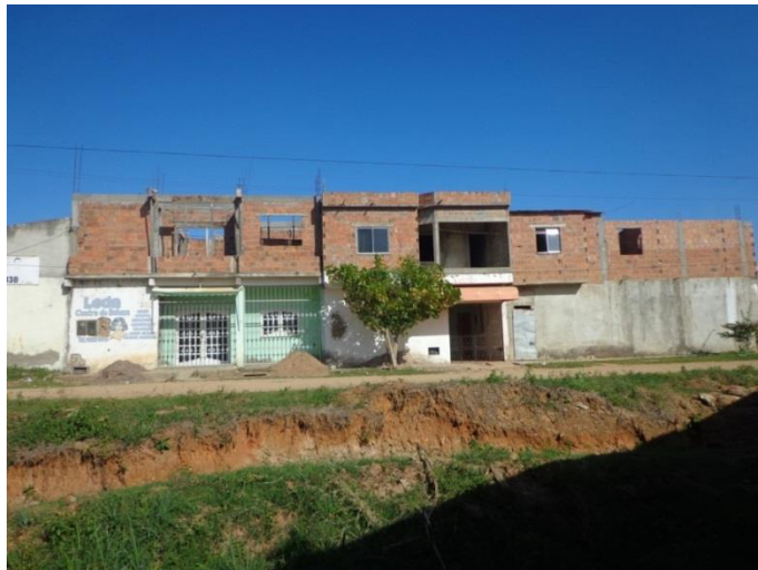
Figura 3.16 – Casas em fase de obras para construção de um novo pavimento.
