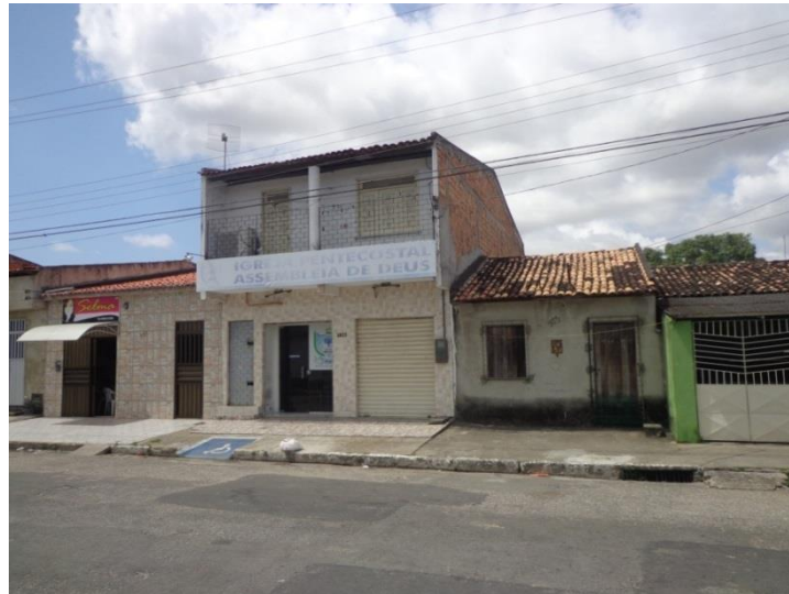
Figura 3.42 – Casas, igreja e salão de beleza serão retirados para passagem da avenida.
