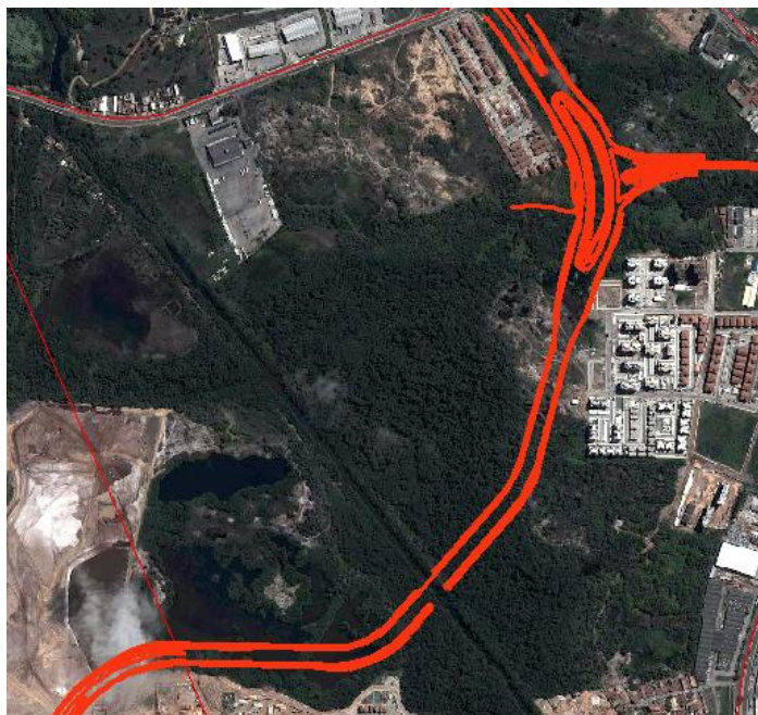
Figura 6.7 – Trecho da Perimetral que percorre áreas de floresta inundável nas margens do Rio Poxim.
