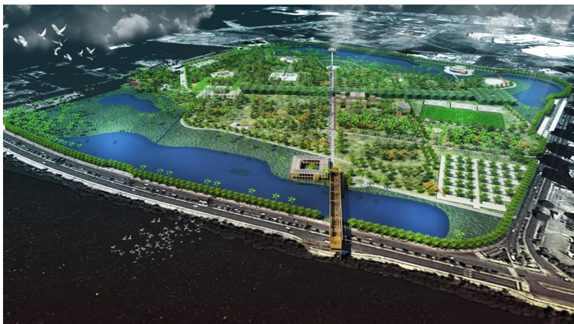
Figura 4.8 – Parque da Sementeira (projeto de revitalização).
