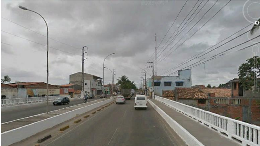
FIGURA 16 – ESTAÇÃO PONTE – SÃO CONRADO – ALARGAMENTO DE 4,00 m
