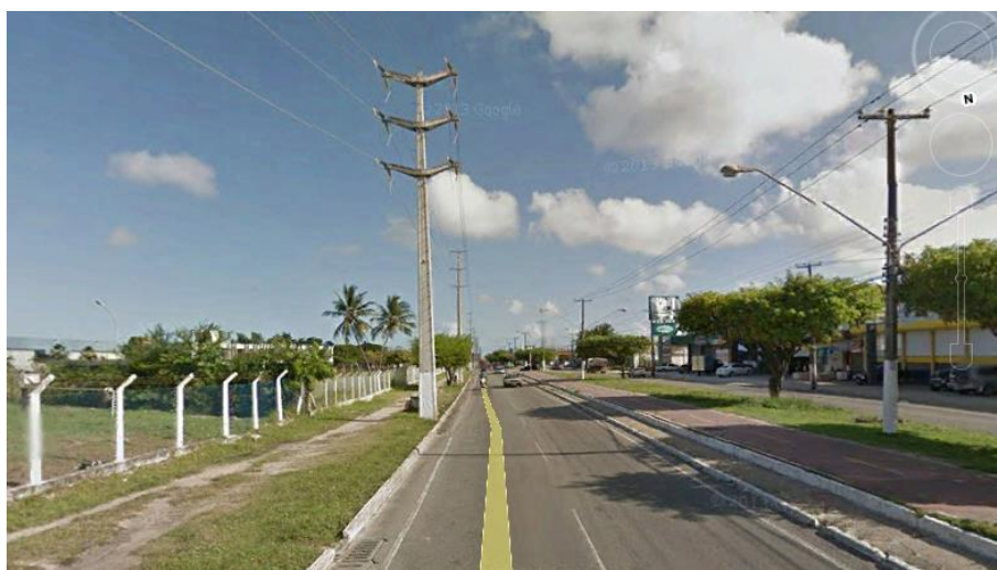
FIGURA 15 – ESTAÇÃO TRAVESSA H
