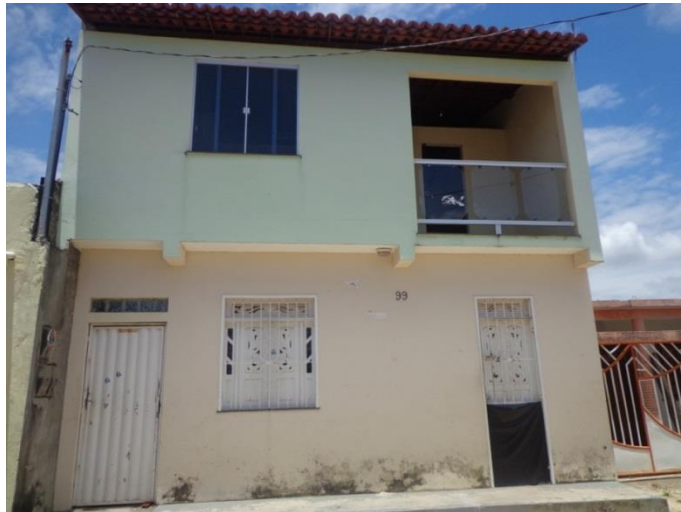
Figura 3.3 – Casa com dois pavimentos que será retirada para passagem da avenida.
