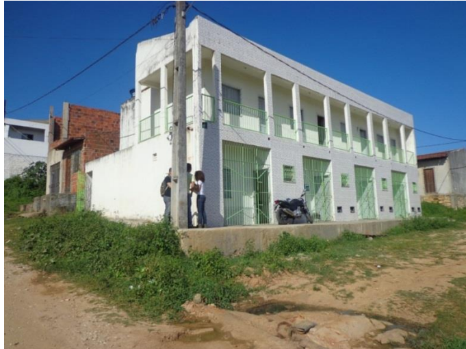
Figura 3.15 – Casa subdividida em oito moradias.
