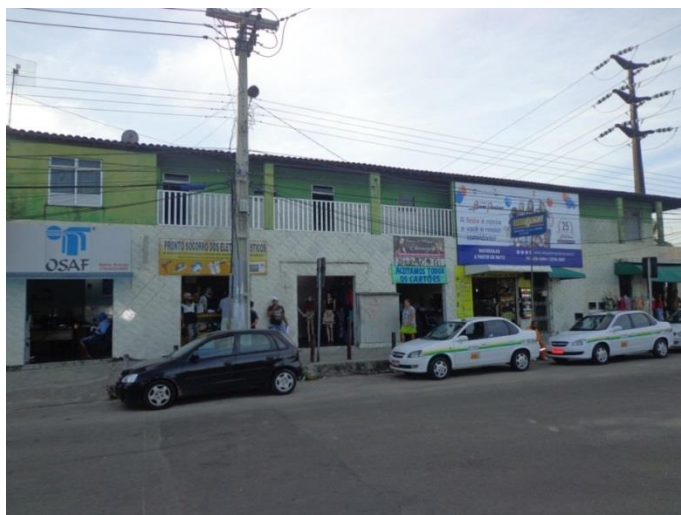
Figura 3.28 – Área comercial que deverá ser retirada para passagem da avenida.
