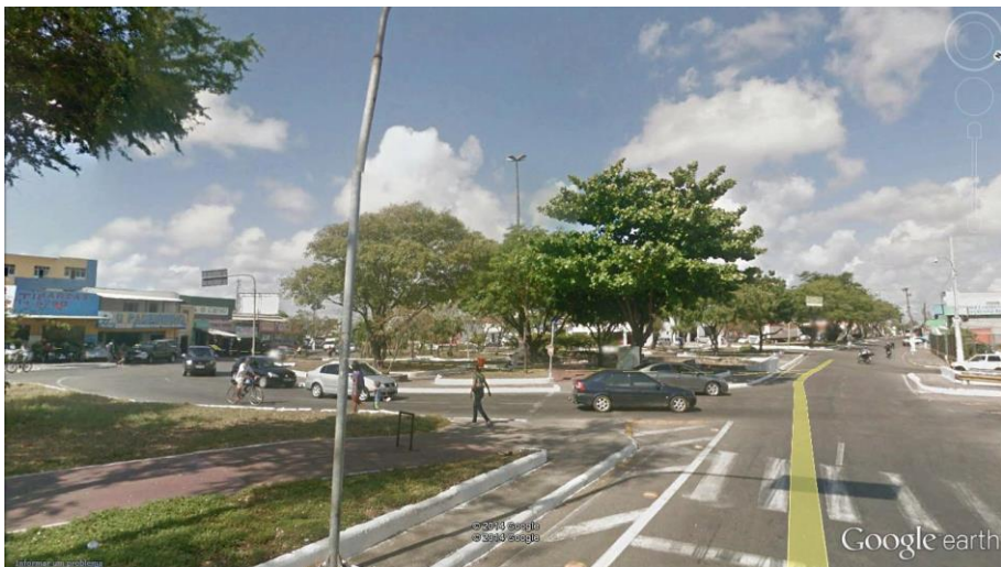
FIGURA 23 –ESTAÇÃO GENTIL TAVARES – SUPRESSÃO DE ARVORES
