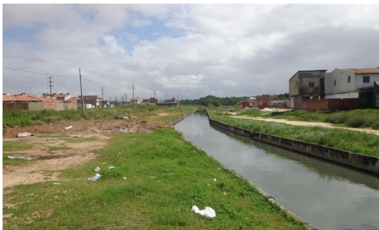
Figura 6.1 – Canal que será urbanizado e ficará no meio do trecho de prolongamento da Av. Juscelino Kubistchek.
