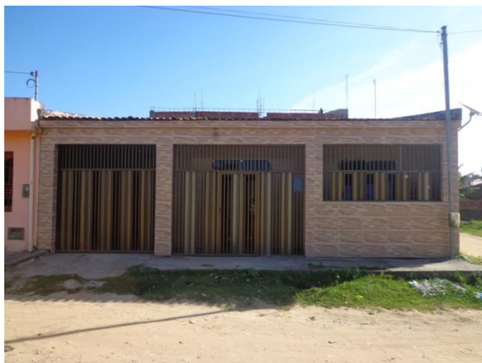
Figura 3.17 – Casa aparentemente bem estruturada que será removida para passagem da avenida perimetral.
