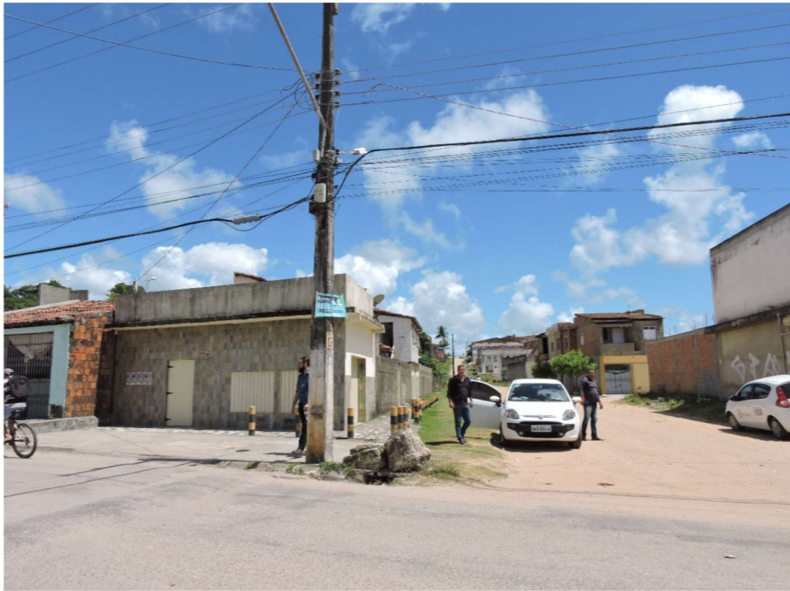
Foto 4 Soledade – Imóveis sujeitos à remoção.
