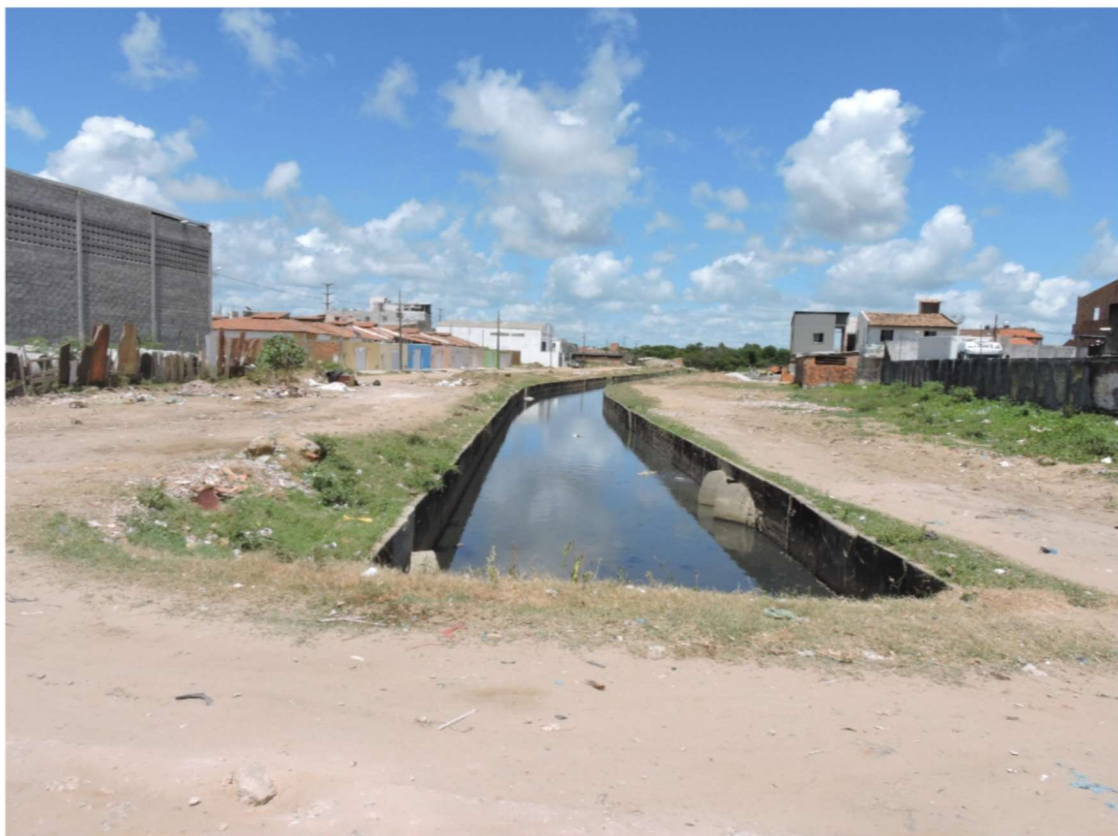
Foto 5 Soledade- Início da interconexão com Avenida Maracaju- Imóveis parcialmente afetados.
