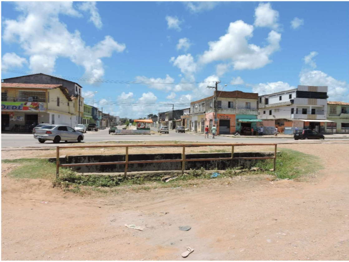
Foto 8– Jardim Centenário – Avenida Santa Gleide-Fim do Trecho a ser construído. Imóveis à direita da foto, sujeitos a remoção.
