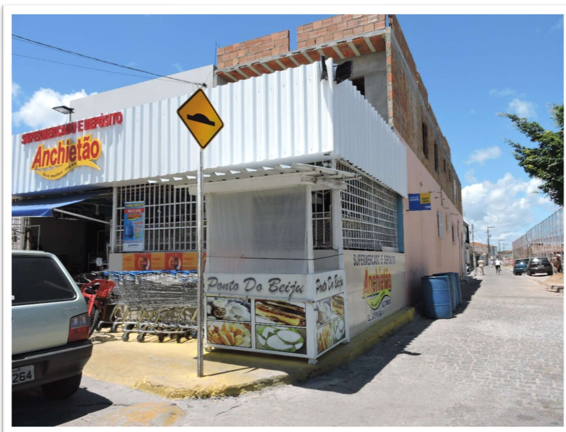
Foto 7– Bugio- Estabelecimento Comercial sujeito à remoção.
