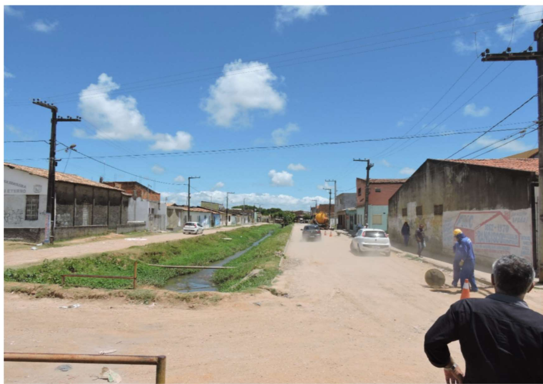
Foto 9– Jardim Centenário- Último trecho da Avenida Perimetral Oeste- Imóveis sujeitos à remoção. Do lado esquerdo do canal, é território do município de Nossa Senhora do Socorro.
