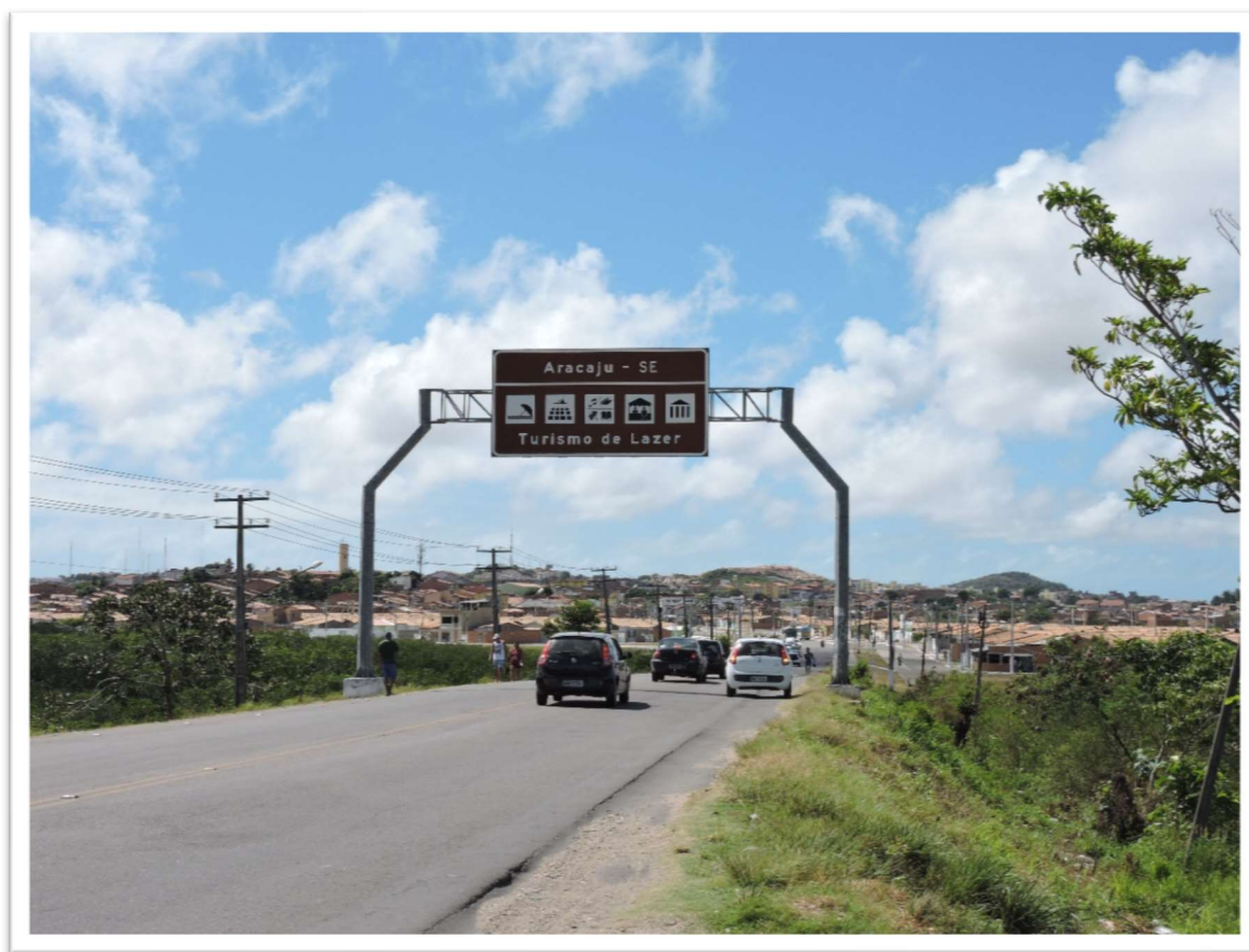
Foto 1 Lamarão- Início da Avenida Perimetral
