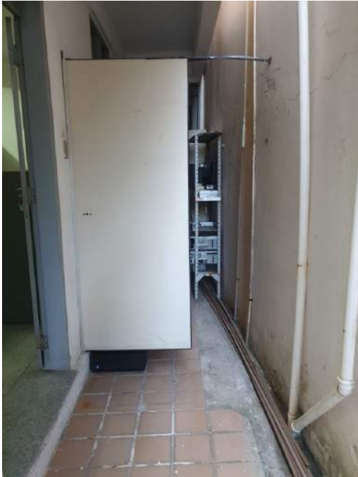
Imagem 03: Entrada do Depósito Depois Depois
