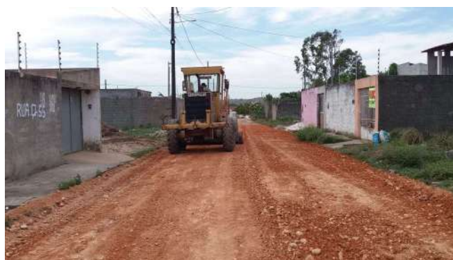
Rua 'Q' - Lot. Costa Verde - Zona de Expansão
