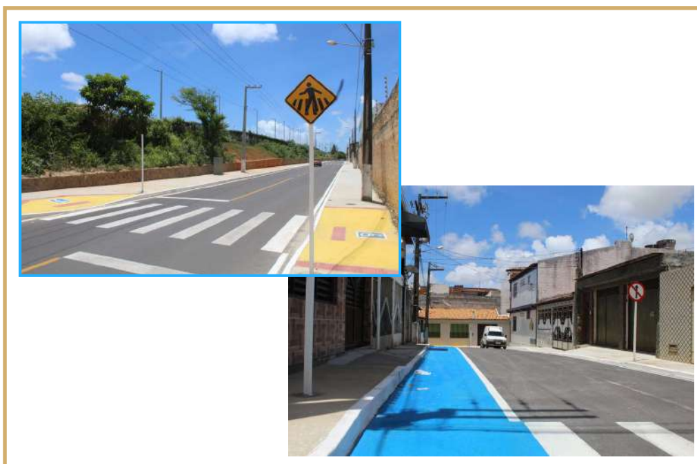
Infraestrutura do Lot. Expansão Siqueira Campos - Bairro 18 do Forte
