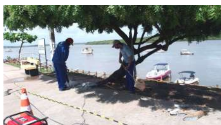
Recuperação do pavimento da Orla Por do Sol
