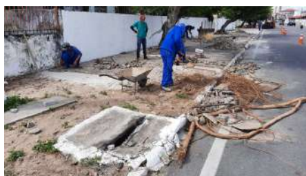
Recuperação de calçada na Av. São João Batista - Ponto Novo
