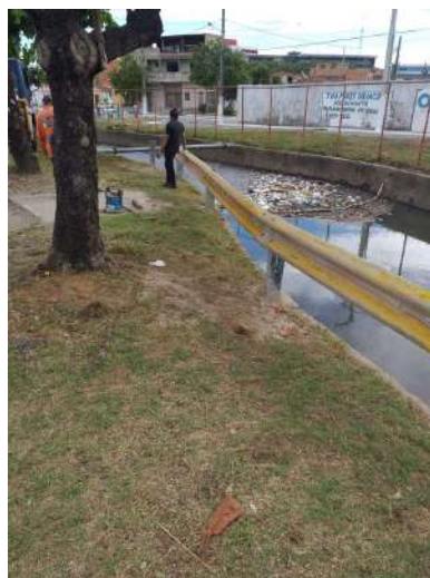
Implantação de defesa metálica no canal do bairro Olaria
