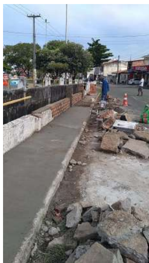
Recuperação de mureta e passeio do canal da Av. Visconde de Maracaju
