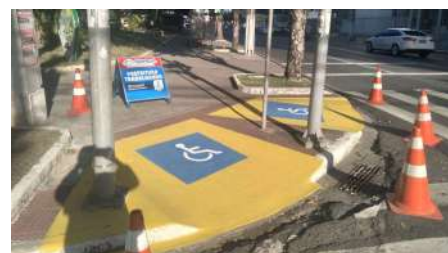
Pintura de sinalização de acessibilidade na Praça Camerino
