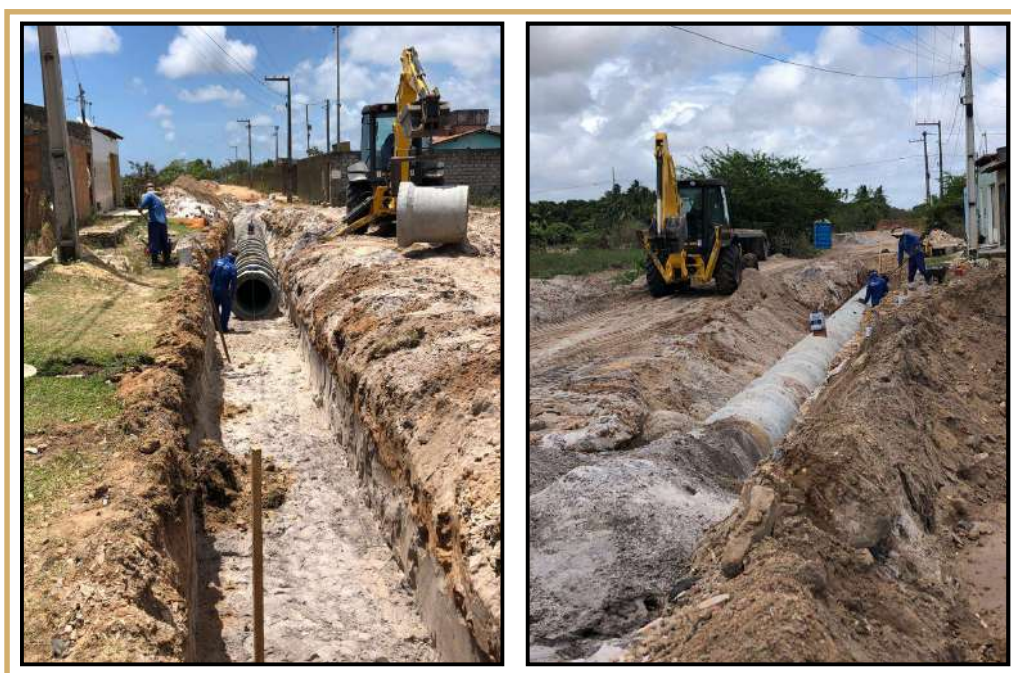
Infraestrutura da Av. Alexandre Alcino - Bairro Santa Maria
