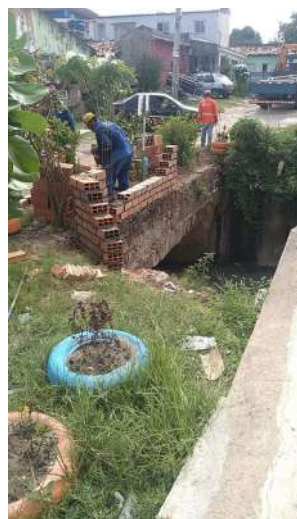
Construção de muro de proteção no canal Comandante Miranda
