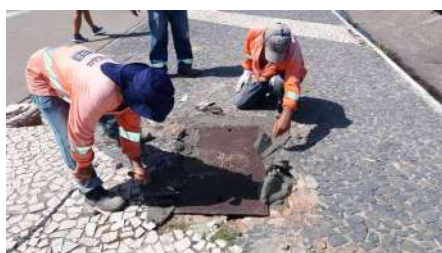
Recuperação do pavimento da Praça de Eventos da Orla
