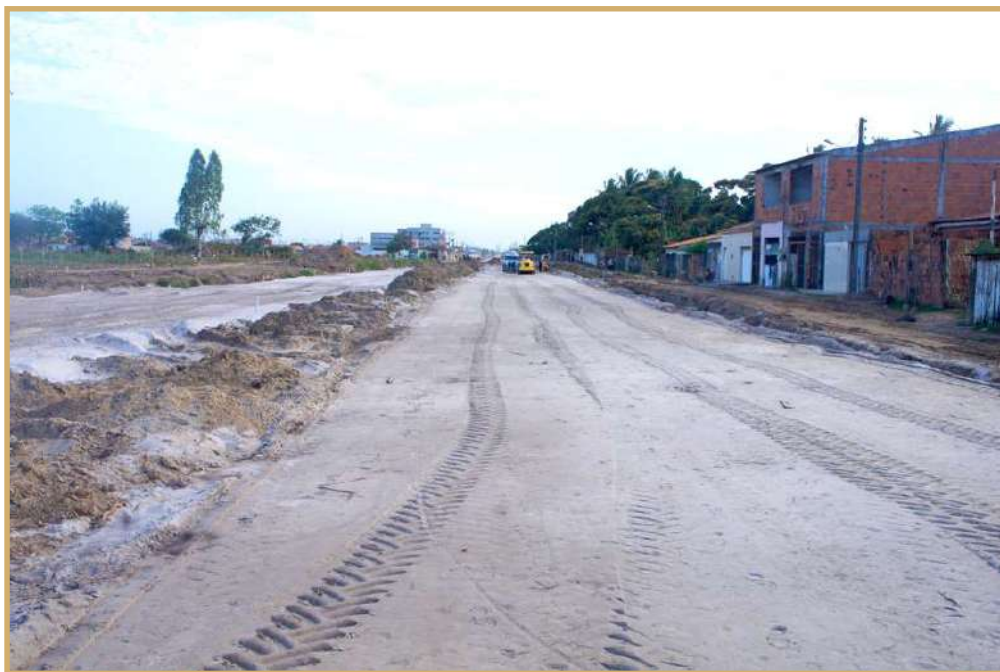
Interligação das Avenidas Alexandre Alcino e João Batista Costa - 17 de Março
