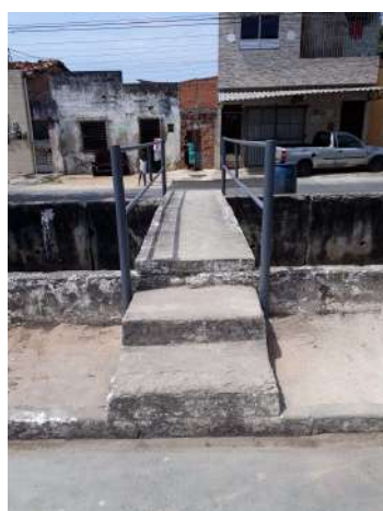
Instalação de guarda-corpos nas passarelas do canal da Avenida Filadelfo Dórea - Industrial
