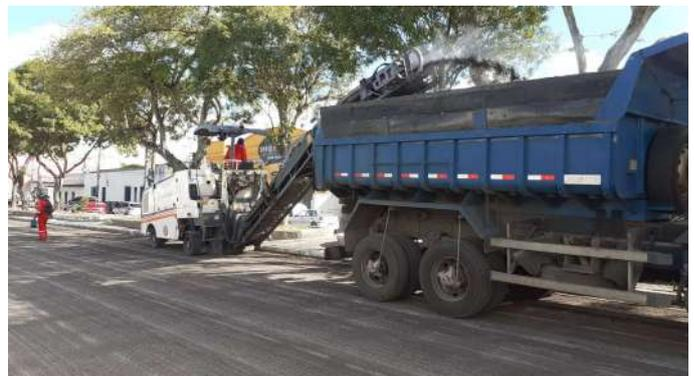
PAVIMENTAÇÃO COM ASFALTO FRESADO
