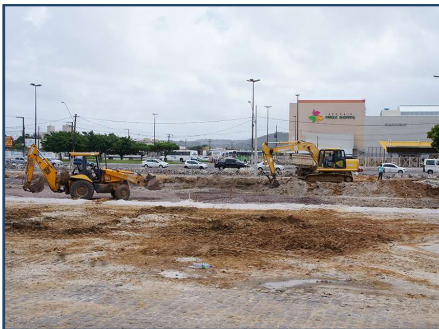
Construção do novo terminal do mercado - Centro
