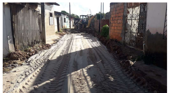
Av. Canal 4, Lot. Nova Liberdade, bairro Olaria
