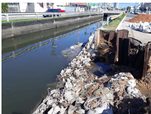
Recuperação da parede do canal da Av. Anísio Azevedo - 13 de Julho
