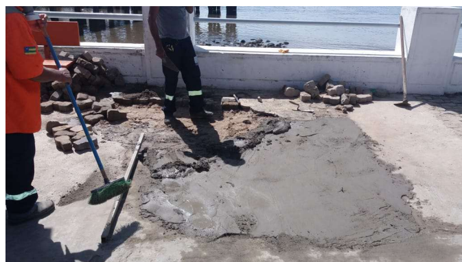
Recuperação de passeio da Av. Ivo do Prado - São José
