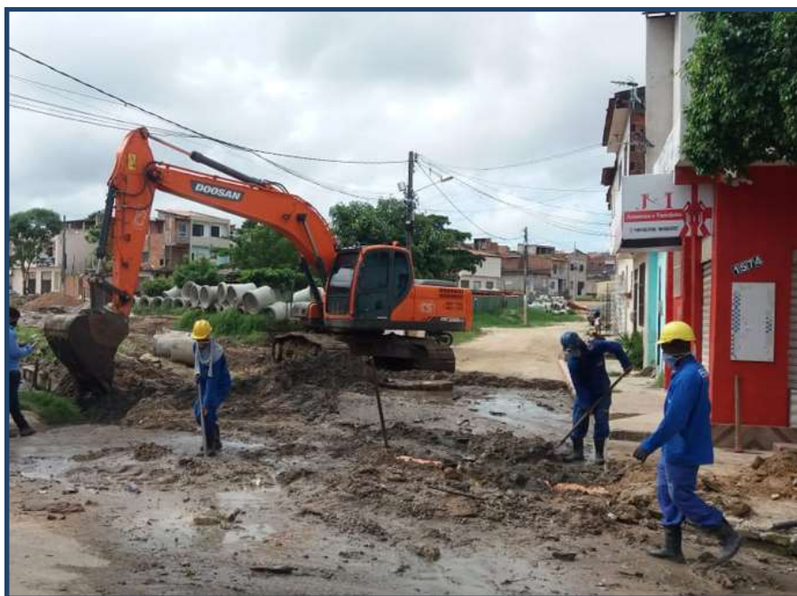
Infraestrutura do Loteamento Tia Caçula - Dom Luciano
