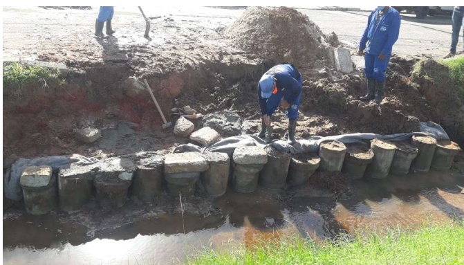
Recuperação do Canal do Residencial Costa Nova - Zona de Expansão
