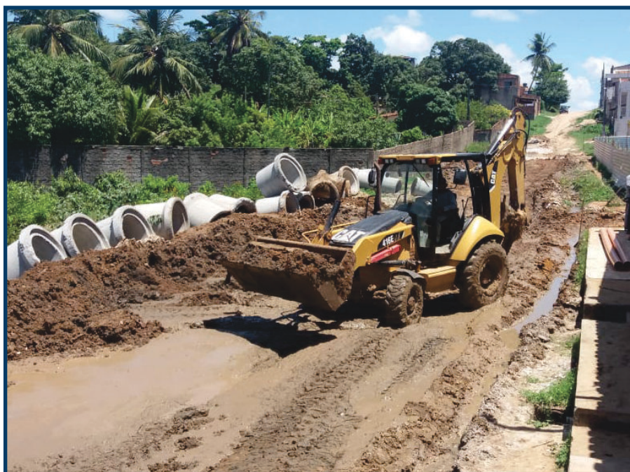
Infraestrutura do Loteamento Isabel Martins - Soledade
