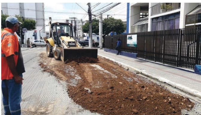
Execução da base do pavimento da Rua Itabaiana - Centro
