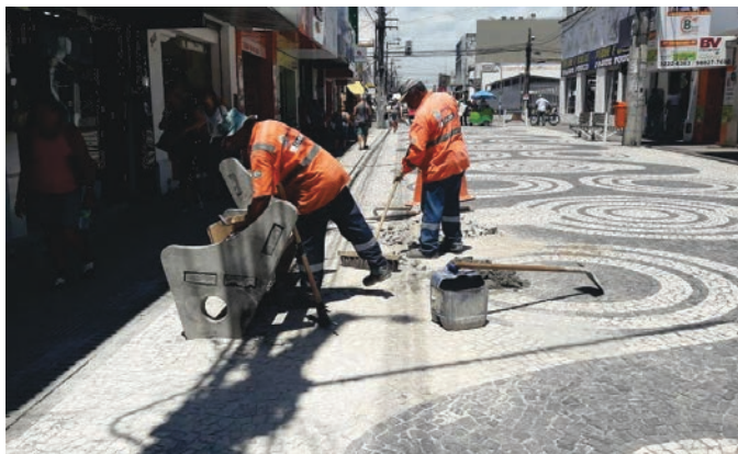
Assentamento de bancos no Calçadão da Rua Laranjeiras - Centro
