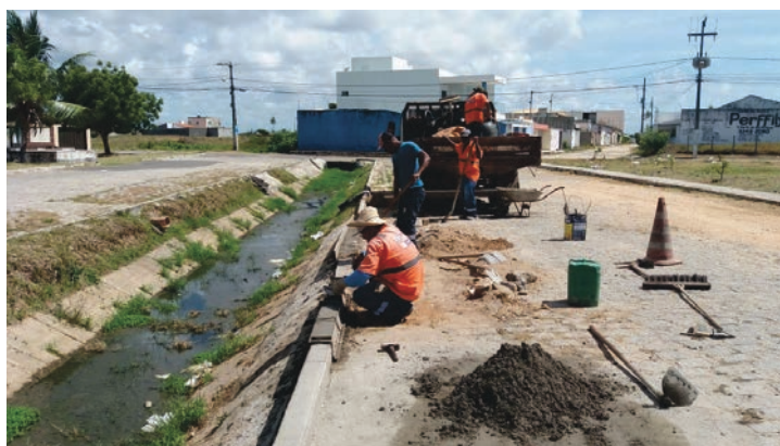
Recuperação de meio-fio do canal da Av. Cel. Tadeu Cruz, Zona de Expansão
