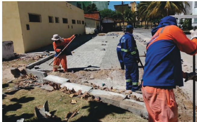
Assentamento de meio-fio na Praça do Cj. Beira Mar - Aeroporto
