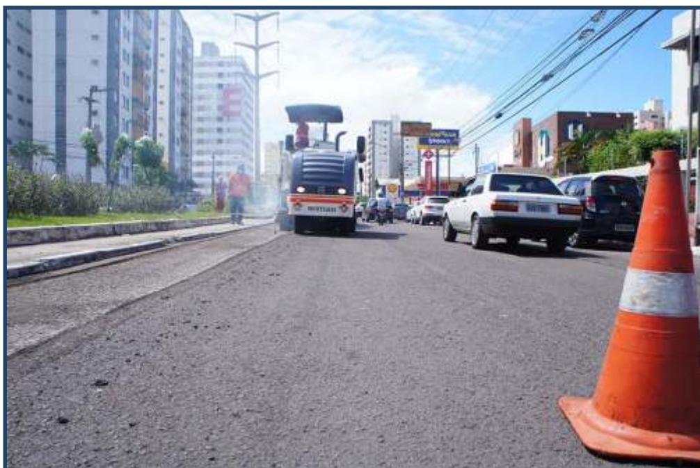
Fresagem e recapeamento asfáltico da Av. Gonçalo Rollemberg Leite
