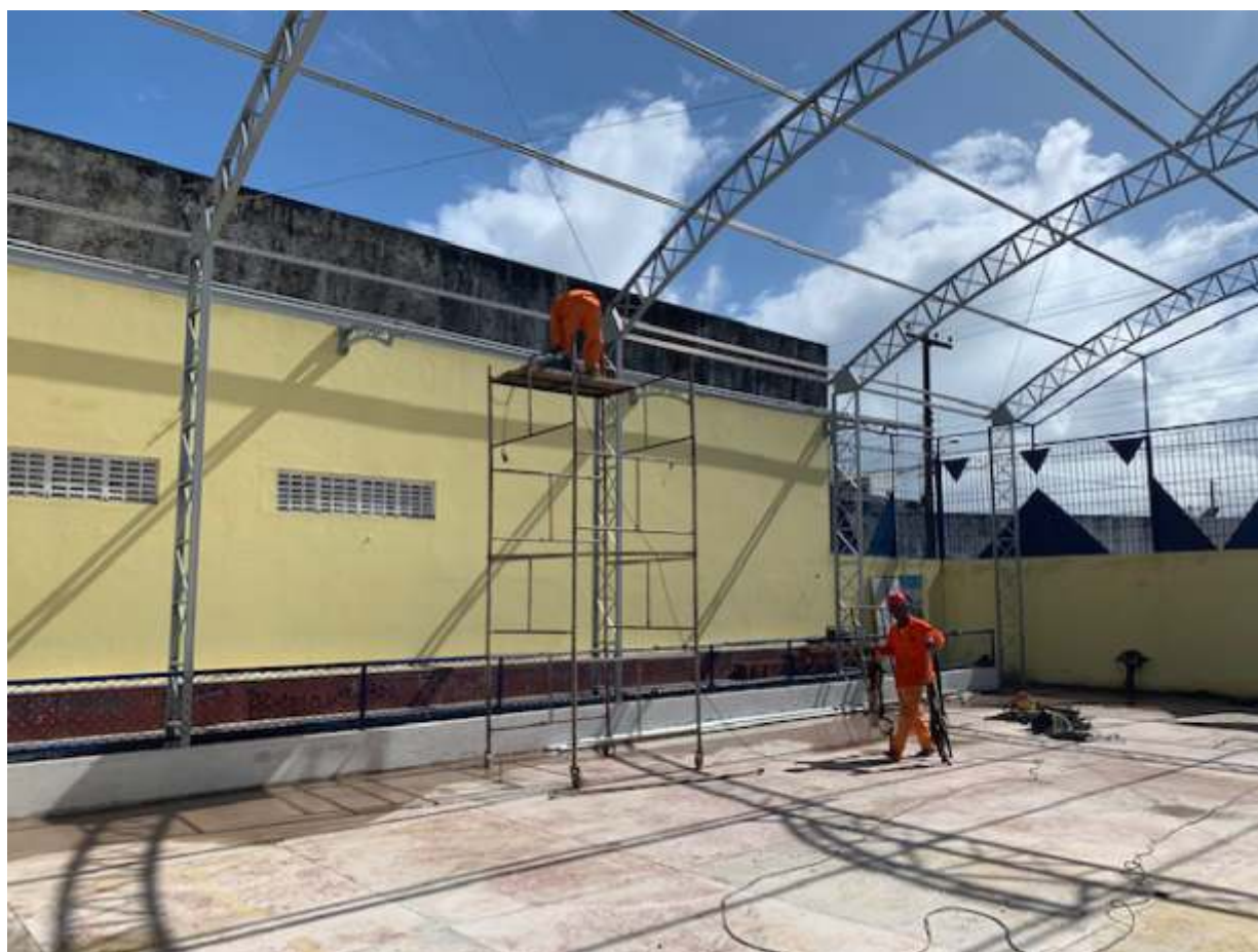
EMEF MANOEL BOMFIM - Bairro: Bugio
