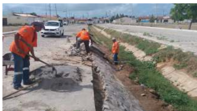
Recuperação de canal Res. Costa Nova - Zona de Expansão
