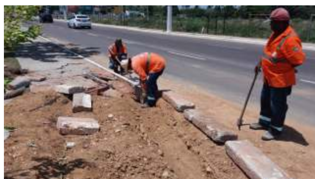
Assentamento meio-fio na Av. Ver. Manoel Dórea - Farolândia
