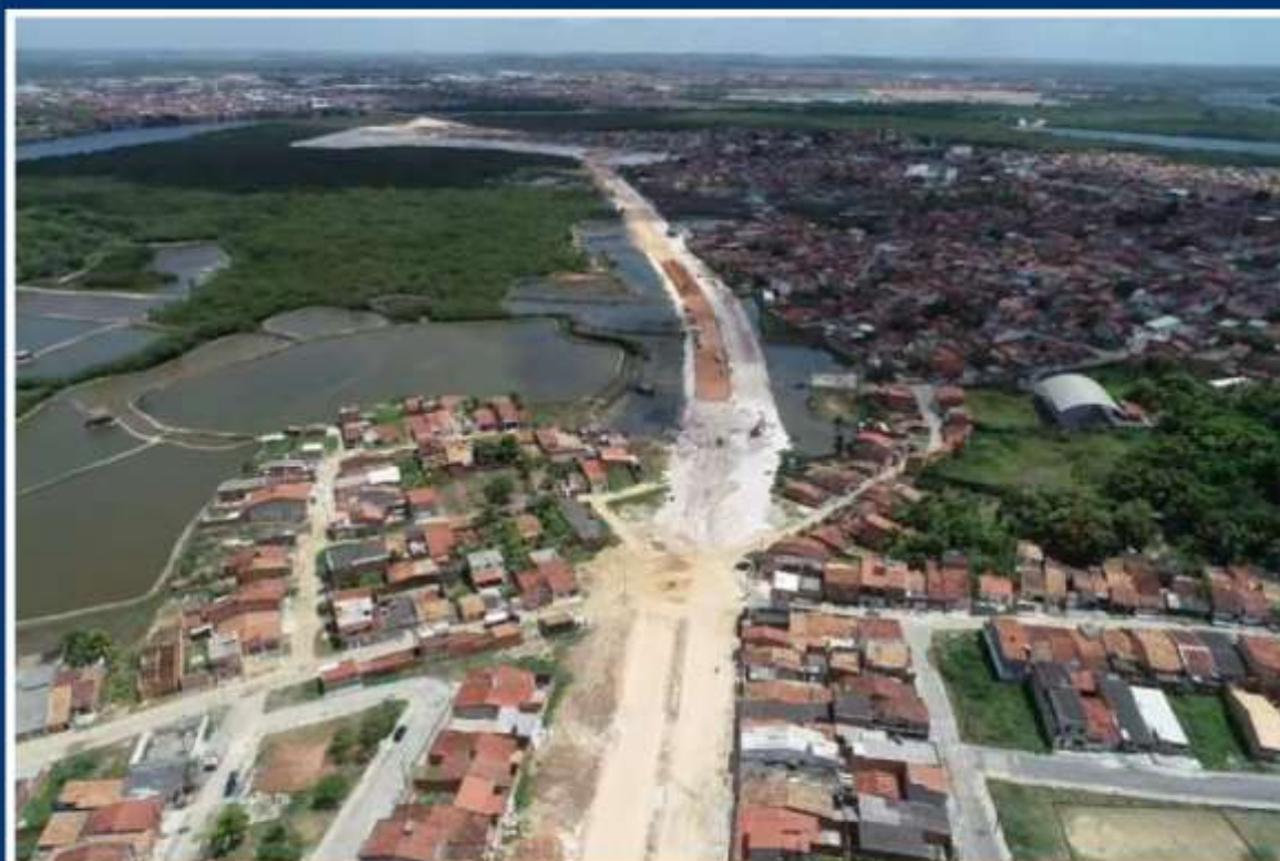
Construção da Av. Perimetral Oeste - Bairros Bugio/Soledade/Jardim Centenário/Lamarão
